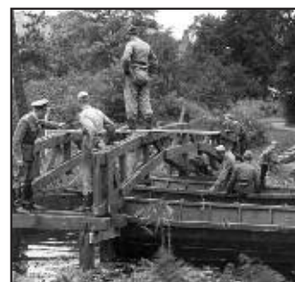
Saperzy z Oficerskiej Szkoły Wojsk Inżynieryjnych przy budowie mostu na stawie, 1958. Archiwum OBUWr.
