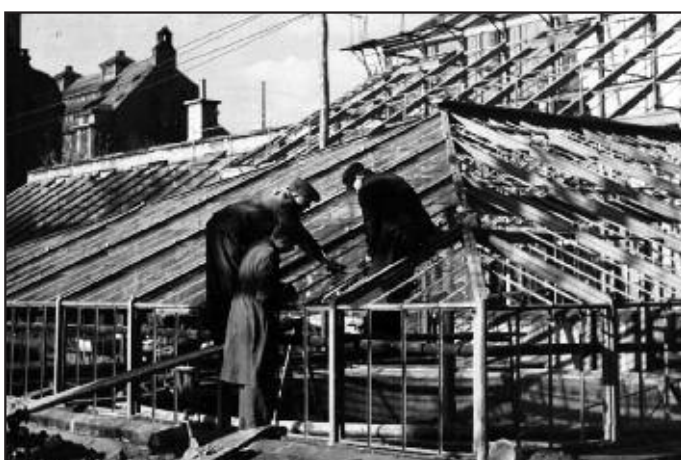
Odbudowa pawilonu wiktorii, przed 1957.
